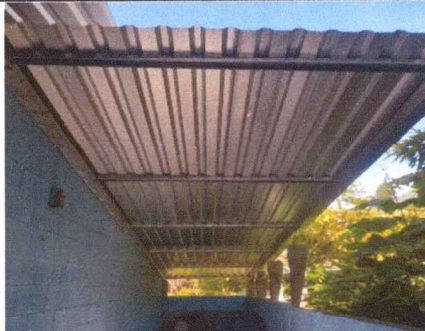
Foto 4: Cubierta de lámina troquelada calibre 26 y estructura sustituidos en su totalidad en área de servicios sanitarios.
