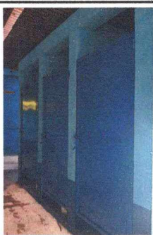
Foto 5: Puertas de Metal de Servicios Sanitarios sustituidos en su totalidad.
