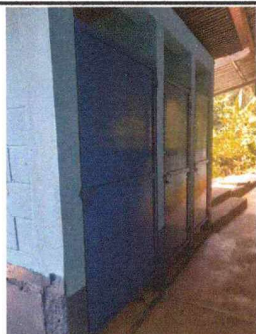
Foto 5: Puertas de Metal de Servicios Sanitarios sustituidos en su totalidad.
