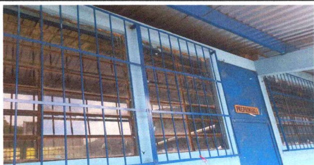
Foto 3: Vidrios y balcones sustituidos.
