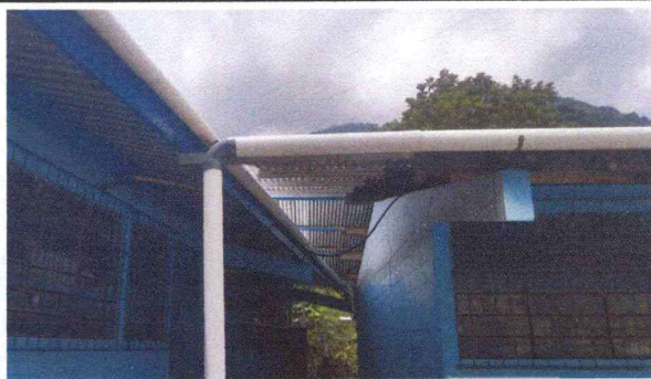
Foto 2: Cubierta de lámina y estructura instalada.
